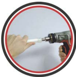
Вставить инструмент и расширить трубу вместе с гильзой
